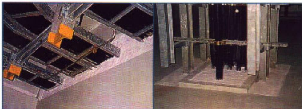
O sistema firemaster é utilizado para proteger dutos de gordura, bandejas de cabos, selagem de penetração, juntas de dilatação e shaft's, com proteção de 3 horas contra fogo, permanecendo com suas propriedades inalteradas após o sinistro; garantindo as seguintes características:
