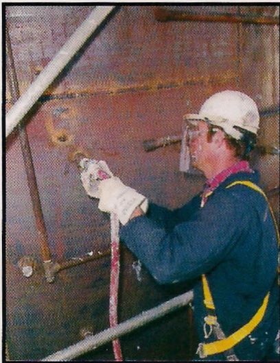
Produto Bombeável Kaowool Pumpable, sendo bombeado para reparo de um ponto quente
