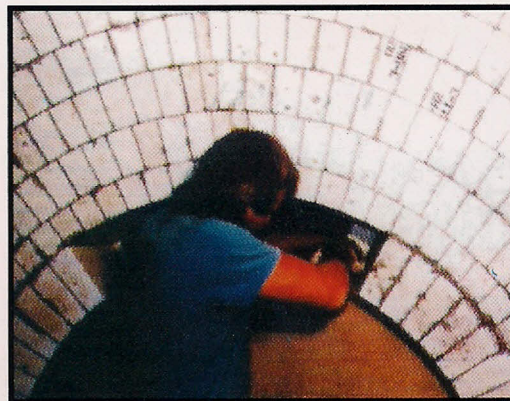
Unidade de Recuperação de Enxofre - Parte Superior
