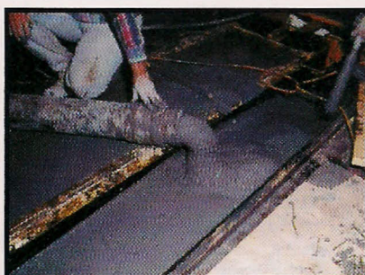
Aplicação por bombeamento
