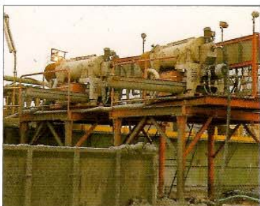
Recuperação de lama de perfuração
