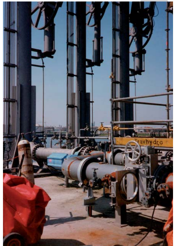
Obturador ONIS PLR 16" instalado em braços de carregamento de nafta
