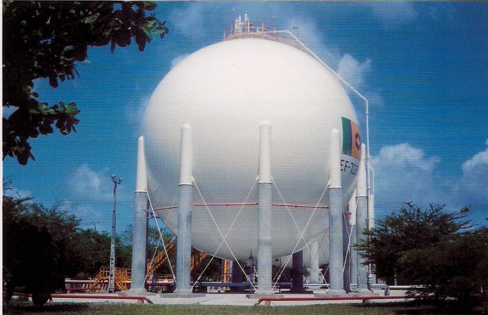
▲ Esfera de armazenamento de gás a alta pressão
